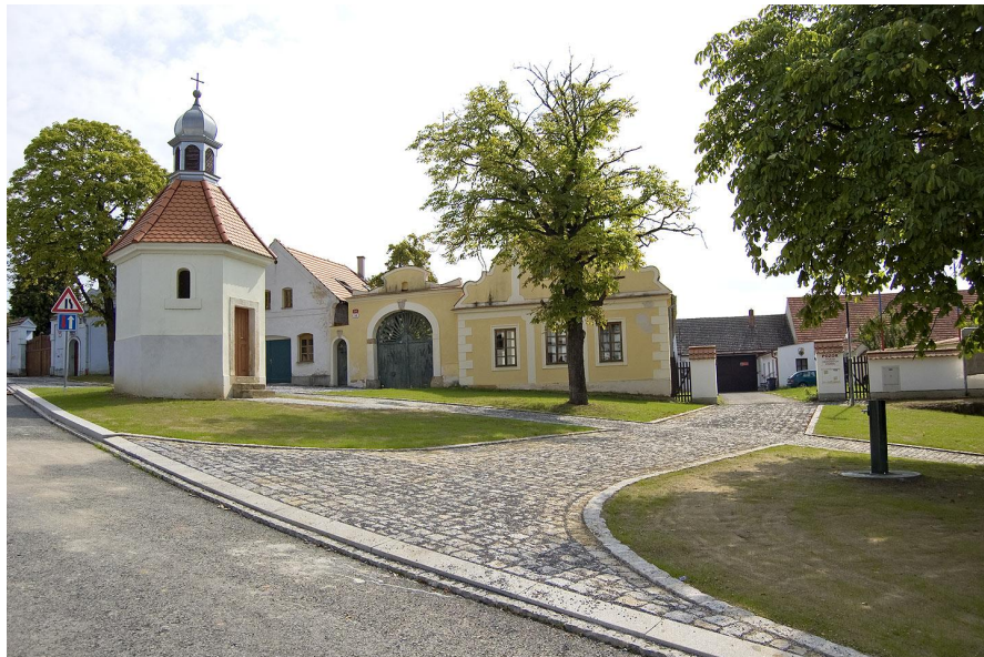
žulová dlažba, zvýšený nájezd na pojezdný chodník
