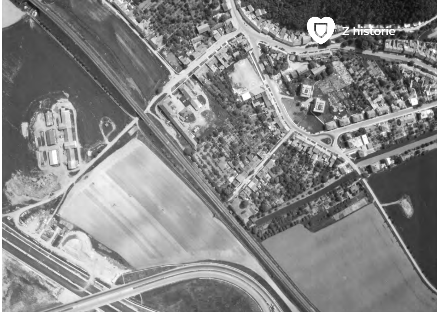
Letecký zeměměřičský snímek Ostopovic z roku 1975 s patrnými bytovkami a stavbou dálnice D1 v bezprostřední blízkosti.
